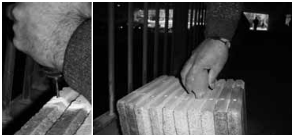
Obrázek 8, 9. Příprava otvorů pro kotvy
