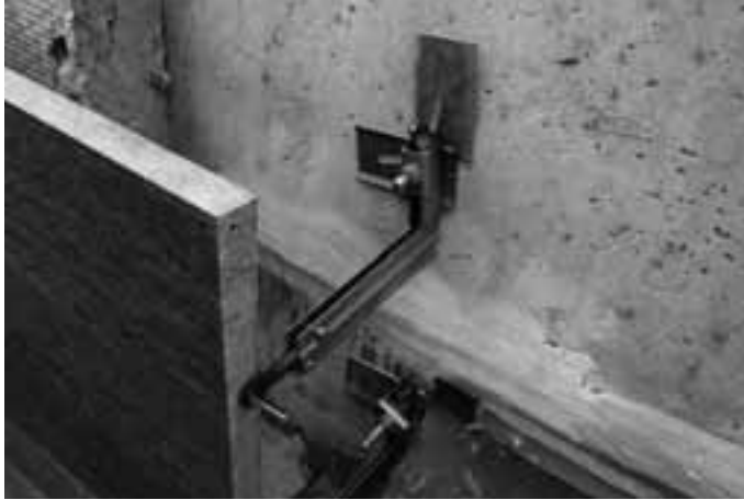
Obrázek 15. Ukončení desek u atiky
