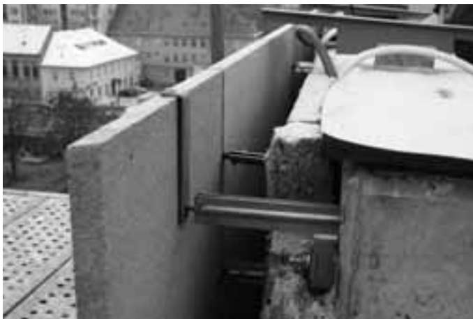
Obrázek 16. Řešení parapetu
