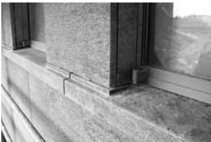
Obrázek 16. Řešení parapetu
